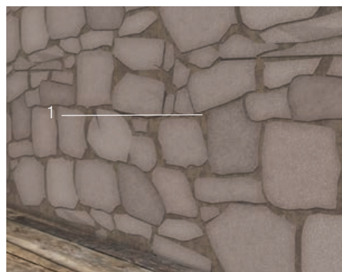
Ristilatura dei giunti.
