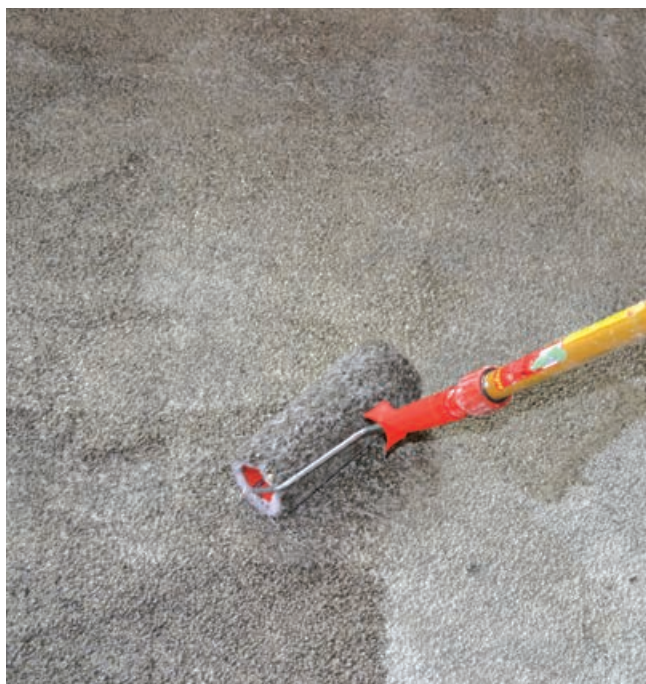
Impermeabilizzazione soletta collaborante in Calcestruzzo CentroStorico.
