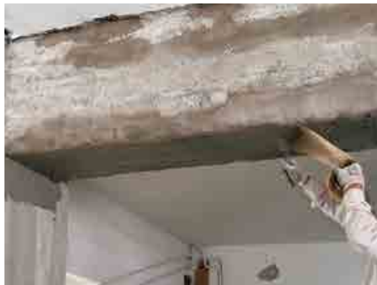
Rinforzo a flessione: posa della matrice inorganica MX-PBO Calcestruzzo e rete PBO-MESH lungo la direzione dei ferri longitudinali.
