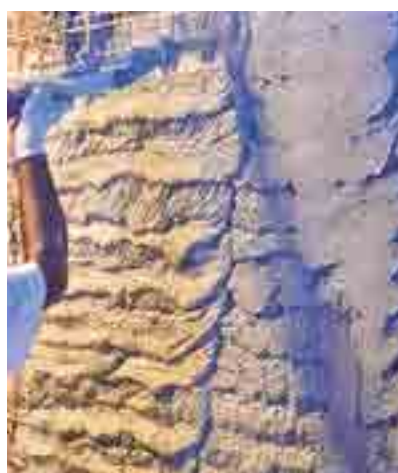
Le pareti in muratura in sasso sono state rinforzate con la tecnologia dell'Intonaco Armato Sistema CRM con le reti Ruregold G-MESH 490, Connettori G-MESH e intonaco strutturale MX-CP Calce a base di calce idraulica naturale NHL 3.5.
