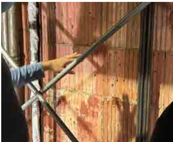
Pareti del vano ascensore da rinforzare.
