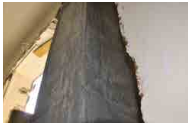
Particolare di pilastro rinforzato con Micro Gold Steel .
