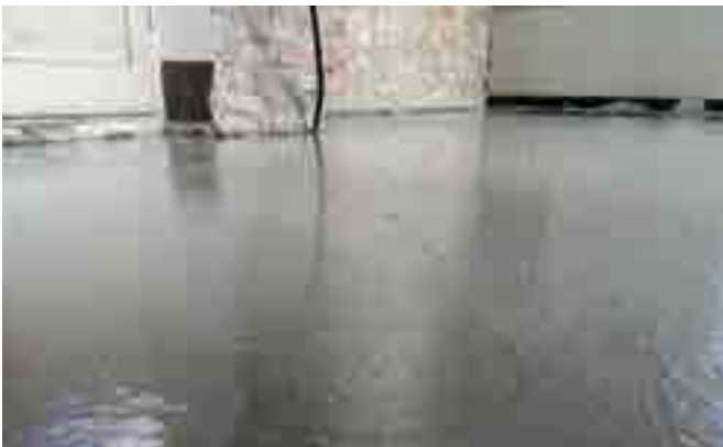
Ripristino estradossale della soletta in c.a. con microcalcestruzzo fibrorinforzato .
