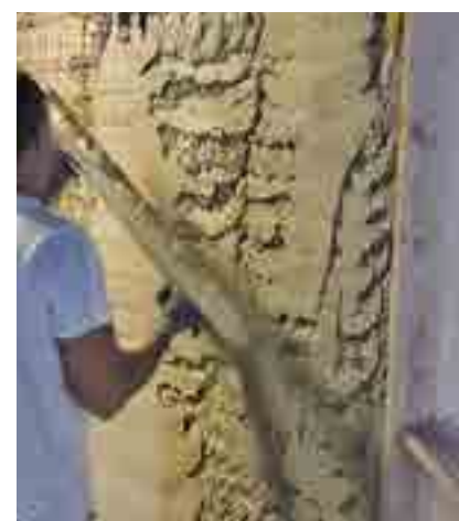
Le pareti in muratura in sasso sono state rinforzate con la tecnologia dell'Intonaco Armato Sistema CRM con le reti Ruregold G-MESH 490, Connettori G-MESH e intonaco strutturale MX-CP Calce a base di calce idraulica naturale NHL 3.5.
