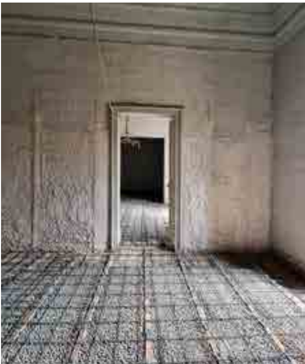
Il solaio è stato consolidato con il metodo della soletta collaborante utilizzando Connettori meccanici CentroStorico Acciaio Incollato e con la posa successiva del Calcestruzzo strutturale leggero LecaCLS 1400 e LecaCLS 1600. Il riempimento tra le putrelle è stato realizzato con argilla espansa Leca sfusa.
