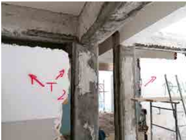
Preparazione del substrato: asportazione del calcestruzzo ammalorato, pulizia dei ferri e applicazione del PASSIVANTE. Ripristino del calcestruzzo (copriferro) mediante malta MX-R4 Ripristino.
