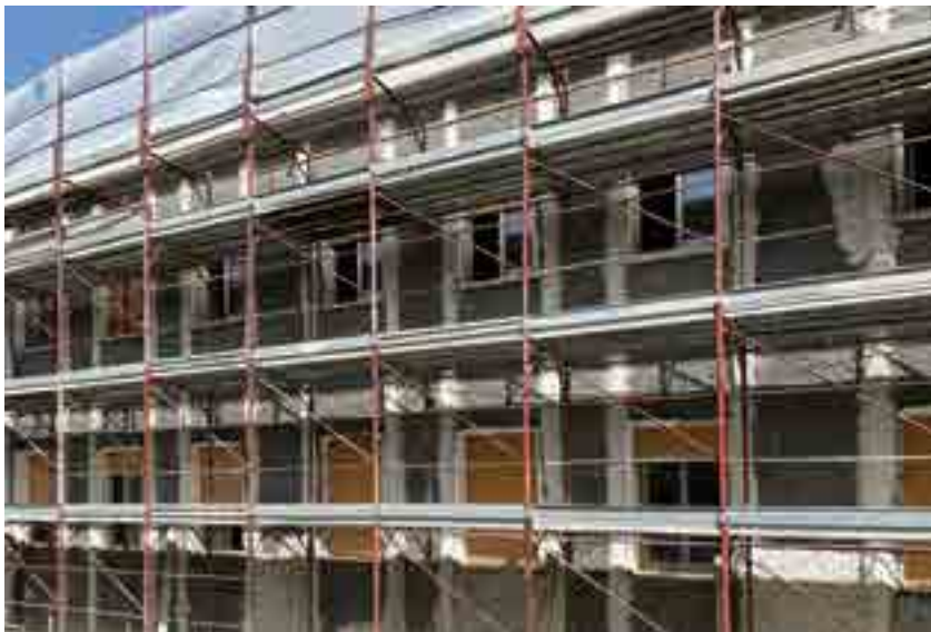
Rinforzo delle pareti in muratura esterne con sistema FRCM posato a traliccio.
