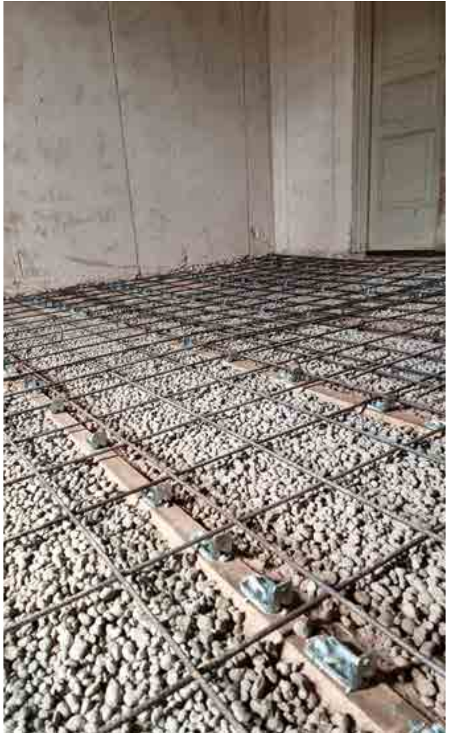
Il solaio è stato consolidato con il metodo della soletta collaborante utilizzando Connettori meccanici CentroStorico Acciaio Incollato e con la posa successiva del Calcestruzzo strutturale leggero LecaCLS 1400 e LecaCLS 1600. Il riempimento tra le putrelle è stato realizzato con argilla espansa Leca sfusa.
