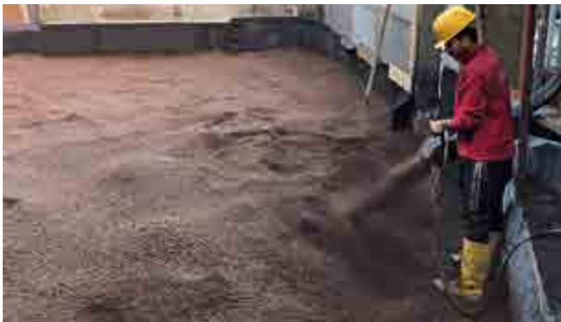
Pompaggio del substrato culturale LecaGreen grazie ad idonei mezzi cisternati.
