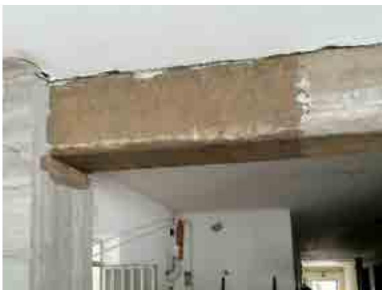
Rinforzo a taglio continuo: Posa della matrice inorganica MX-PBO Calcestruzzo e rete PBO-MESH lungo la direzione delle staffe.
