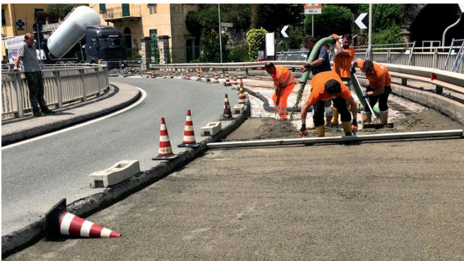
Ponte stradale sulla SS1 Aurelia a Sori (GE). Anno 2021 Leca 2-3 cementato • Massa volumica 800 kg/m 3 .
