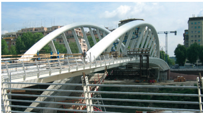
Ponte della Musica a Roma • Anno 2010 • Ponte di Calatrava a Venezia. Anno 2008. Premiscelati LecaCLS 1800 ( R_{ck}=45 MPa, massa volumica=1800 kg/m 3 ) e LecaCLS 1400 ( R_{ck}=25 MPa, massa volumica=1400 kg/m 3 ).
