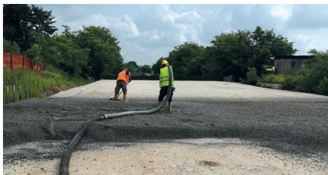
Ritombamento di gallerie artificiali a Monza (MB). Anno 2019 • Riempimento drenante. Leca 8-20 cementata • Massa volumica 500 kg/m 3 .
