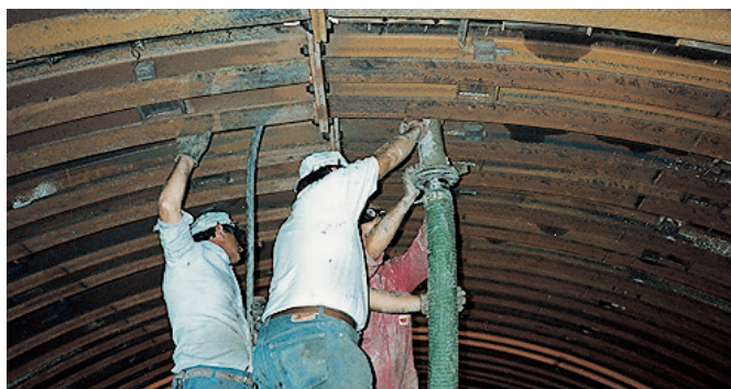
Iniezioni all'intradosso della calotta in galleria sull'Autostrada A30 a Salerno. Anno 2021. Leca Inject • Reoleca.
