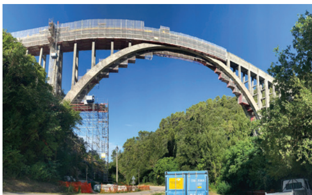
Ringrosso delle travi perimetrali sul Ponte Canale in c.a. Arrone (TR). Anno 2021 Premiscelato LecaCLS 1800 ( R_{ck}=45 MPa, massa volumica=1800 kg/m 3 ).
