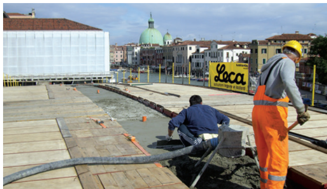
Ponte della Musica a Roma • Anno 2010 • Ponte di Calatrava a Venezia. Anno 2008. Premiscelati LecaCLS 1800 ( R_{ck}=45 MPa, massa volumica=1800 kg/m 3 ) e LecaCLS 1400 ( R_{ck}=25 MPa, massa volumica=1400 kg/m 3 ).
