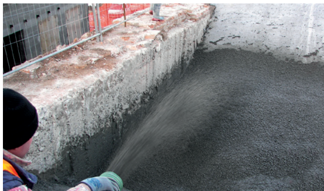
Ponte sul Po a Piacenza. Anno 2009. Leca 8-20 cementato.
