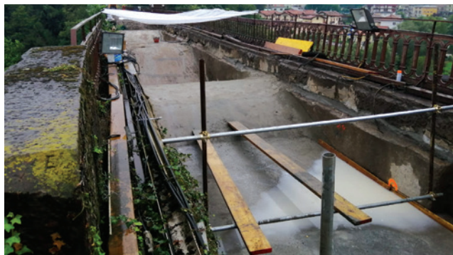
Ponti ferroviari in muratura in Provincia di Bergamo. Anno 2021. Premiscelati LecaCLS 1600 ( R_{ck}=35 MPa, massa volumica=1600 kg/m 3 ) e LecaCLS 1800 ( R_{ck}=45 MPa, massa volumica=1800 kg/m 3 ).
