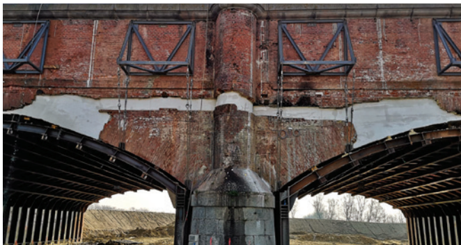
Ponte Canale Cavour a Formigliana (VC). Anno 2020. Calcestruzzo CentroStorico Fluido ( R_{ck}=40 MPa, massa volumica=1800 kg/m 3 ).
