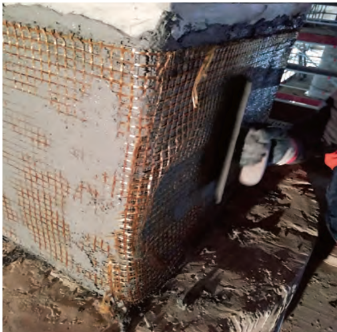
Rinforzo strutturale delle colonne mediante sistema FRCM con PBO-MESH 22/22 e matrice inorganica MX-PBO Muratura.
