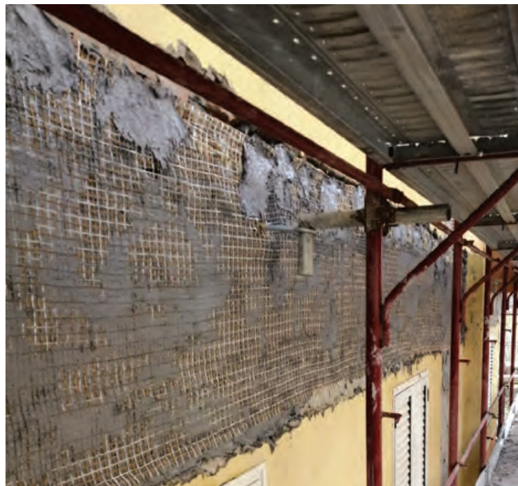
Presidio antiribaltamento in FRCM composto da rete bidirezionale in PBO da 10+10 g/m 2 e da matrice inorganica.
