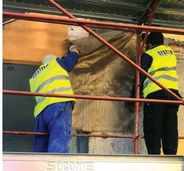
Il Sistema FRCM con rete in fibre di PBO e matrice inorganica è facile da posare e maneggevole. La matrice inorganica si posa come una malta cementizia tradizionale premiscelata in sacco e rende il sistema applicabile anche su supporti umidi e senza l'uso di protezioni speciali.
