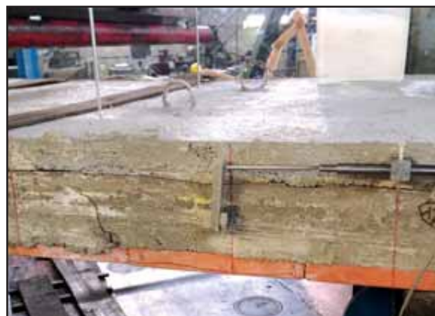
Figura 35: Rottura 2° solaio consolidato h=16 + 5 cm.
