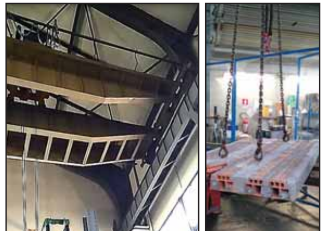
Figura 26: Carro ponte e ganci per sollevare il solaio.
