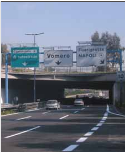
Tangenziale Napoli - Tappeto drenante Anno di esecuzione 2003
