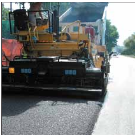
Stesa del conglomerato bituminoso.
