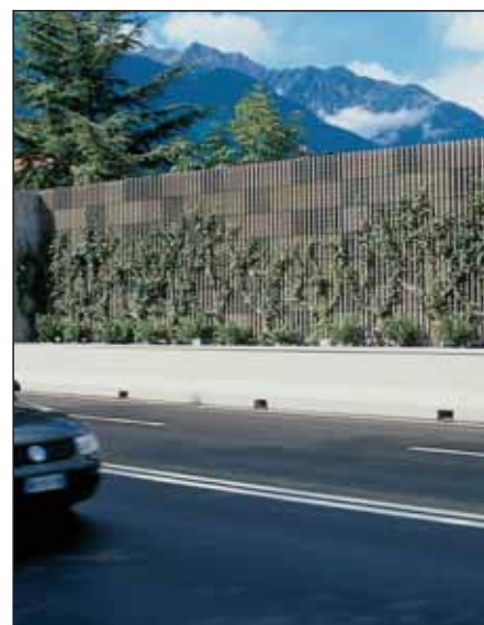
Barriere antirumore con elementi Leca sulla Tangenziale di Modena (sopra) e a Merano - BZ (sotto).
