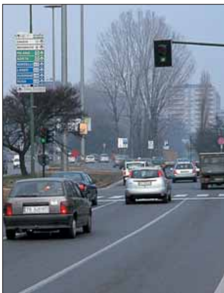
Pavimentazione fonoassorbente realizzata in viale Unità d'Italia nel Comune di Torino.
