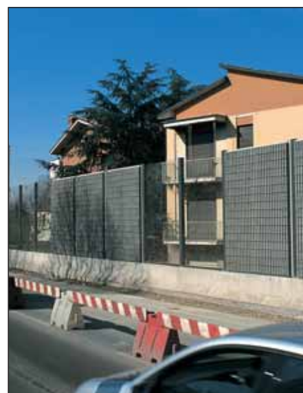
Barriere antirumore con elementi Leca sulla Tangenziale di Modena (sopra) e a Merano - BZ (sotto).
