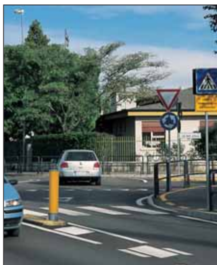
Verona - Tappeto d'usura ad alto fonoassorbimento in un quartiere residenziale. Anno di esecuzione 2003
