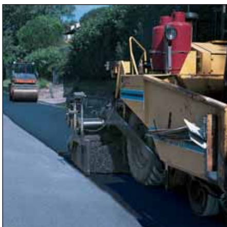
Stesa del conglomerato bituminoso.
