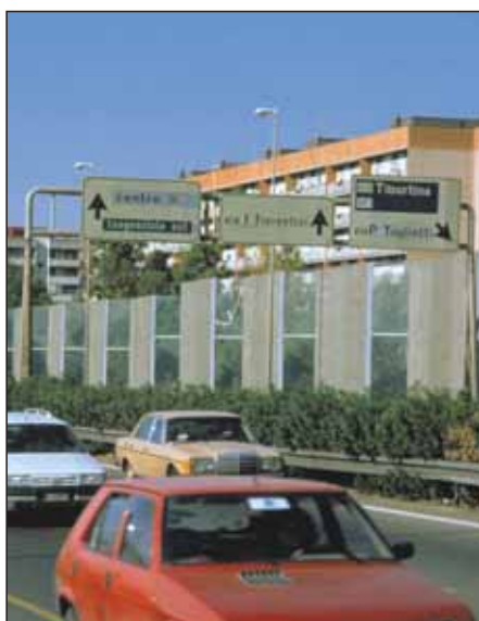
Barriere eseguite con pannelli di calcestruzzo Leca. Valori di assorbimento acustico a compresi tra 0,40 e 0,50 a 500 Hz, e tra 0,45 e 0,70 a 1000 Hz.
