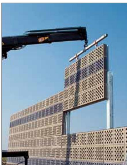
Montaggio di barriere antirumore con elementi Leca solidarizzati ad un pannello prefabbricato in calcestruzzo.
