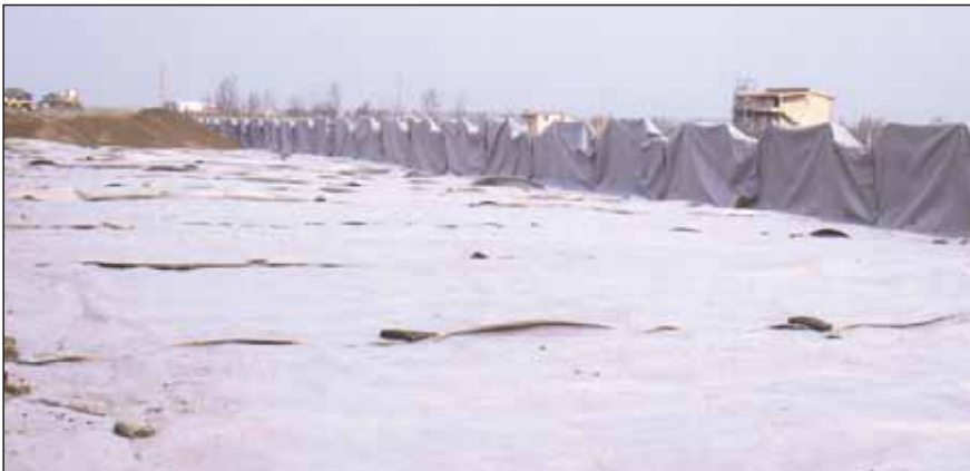
Scavo per la costruzione del rilevato compensato della terza corsia dell'autostrada Roma Civitavecchia.
