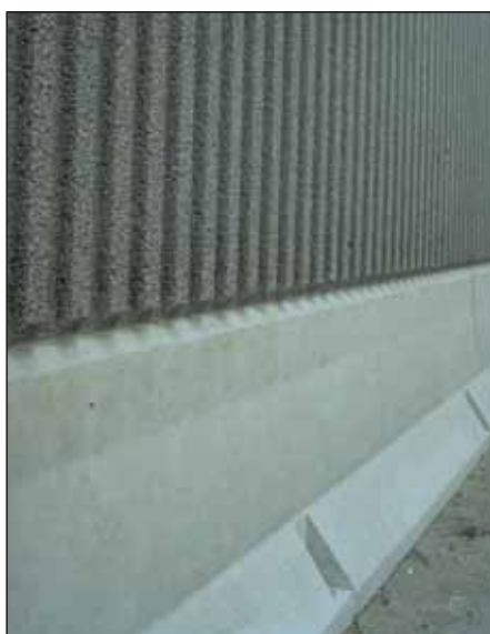
Montaggio di barriere antirumore con elementi Leca solidarizzati ad un pannello prefabbricato in calcestruzzo.
