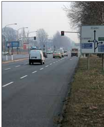
Viale Regina Margherita - Torino Tappeto fonoassorbente Anno di esecuzione 1999
