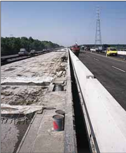
Calcestruzzo collaborante leggero di argilla espansa (densità 1.500 Kg/m 3 ). Ponte sul Po (PC) - Autostrada Milano - Bologna.
