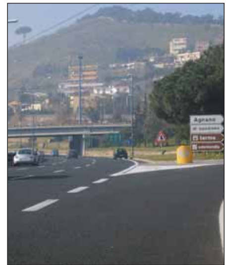
Svincolo di Agnani - Tappeto drenante Anno di esecuzione 2003
