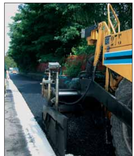
Oltrona (VA) - Tappeto d'usura drenante e ad elevato fonoassorbimento sulla Strada Statale Varese-Laveno. Anno di esecuzione 2003
