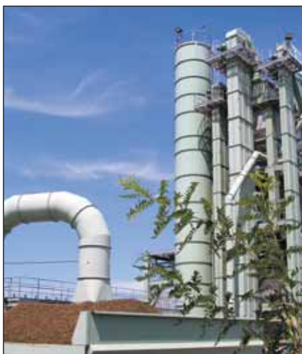
Impianto per la produzione di conglomerato bituminoso.
