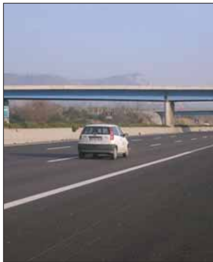
Autostrada Milano Napoli - Microtappeto Anno di esecuzione 2002/2003
