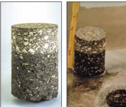
Carota ricavata da conglomerato per rasamento di impalcato dopo 10 anni di esercizio (Viadotto Pantano S.S. Benevento - Telesse)
