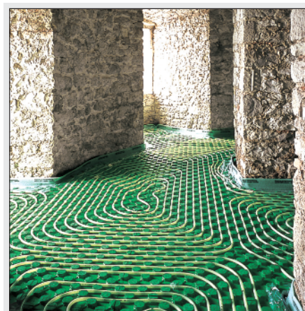
Il pannello isolante e la serpentina riscaldante.
