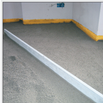
Realizzazione del massetto di finitura.
