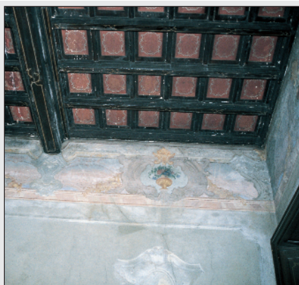
Solaio in legno da consolidare.
