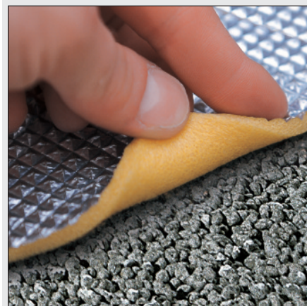
Sottofondo bistrato: posa del materassino.
