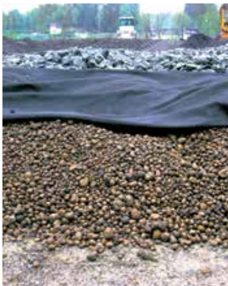
Strato drenante con argilla espansa di granulometria crescente dall'alto verso il basso
