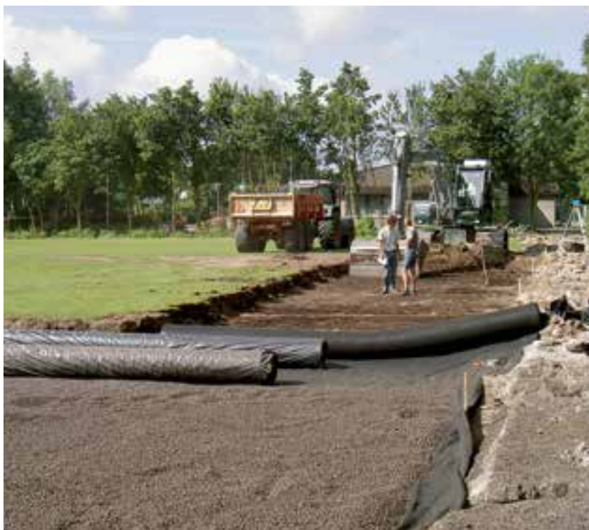
Soluzione sottofondo drenante con argilla espansa. Costruzione al di sotto del tappeto erboso di una serie di livelli di argilla espansa con diversa granulometria.
