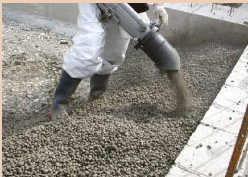
Fondazione a trave rovescia: pompaggio di Leca TermoPiù cementato.
