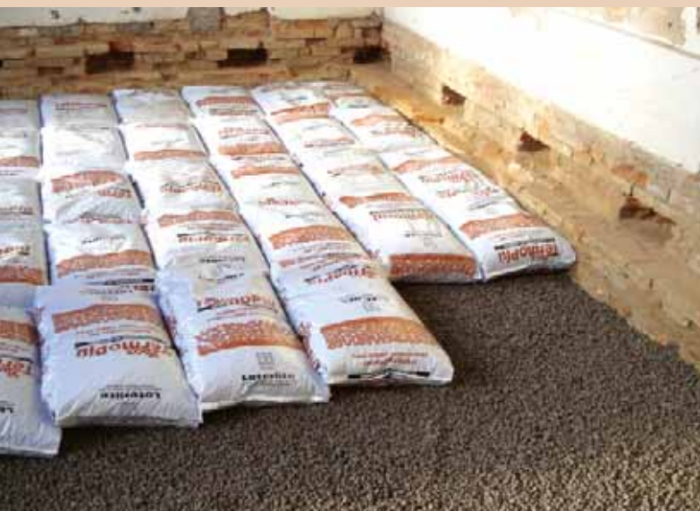
Sottofondo isolato in Leca TermoPiù in sacco.
