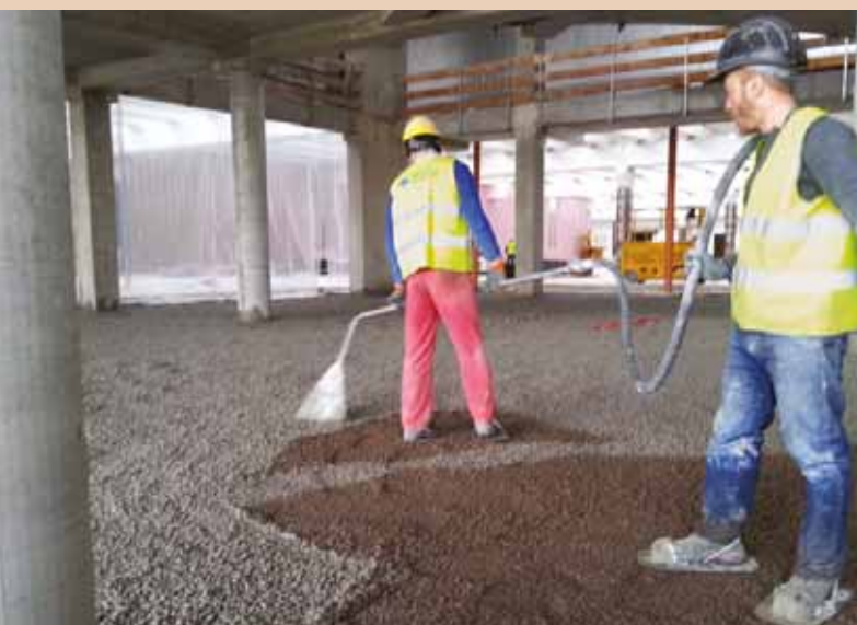
Imboiaccatura del vespaio in Leca TermoPiù.
