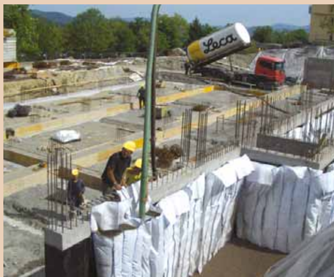
Isolamento termico di pareti verticali interrato con il sistema TermoBag.
