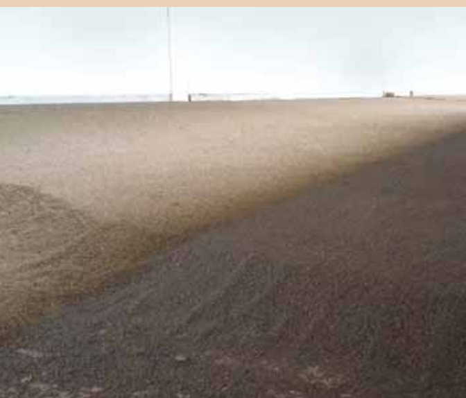
Sottofondo isolato in Leca TermoPiù sfuso.
