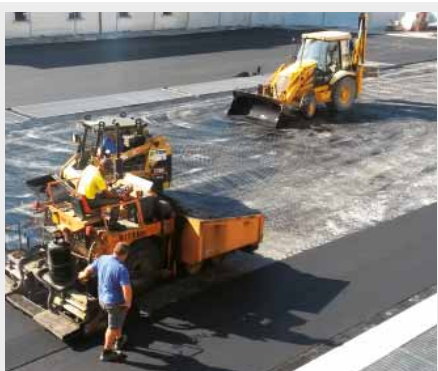
Posa dell'asfalto con macchina finitrice direttamente sullo strato di argilla espansa cementata.
