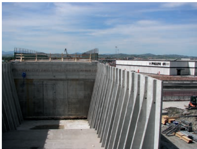
Autostrada A14 - Svincolo di Rubicone.
