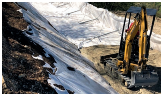
Rilevato su pendio a Ripe di San Ginesio (MC).
