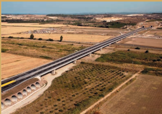
Autostrada Catania Siracusa - Rilevato stradale
