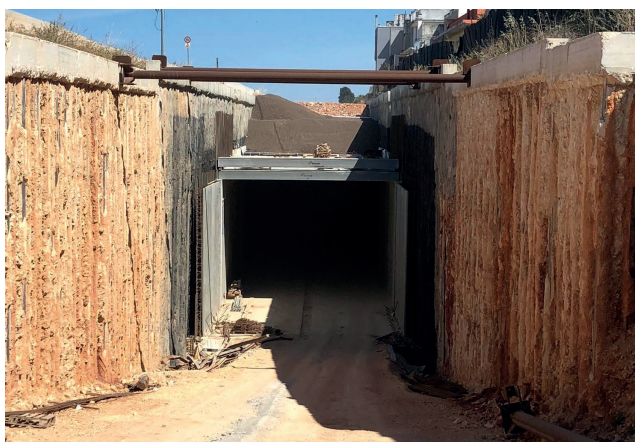
Ritombamento di galleria artificiale ferroviaria in prov. di Bari.
