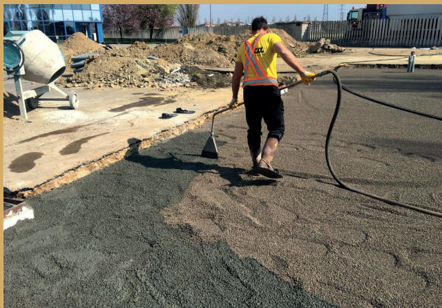
Milano - Fondazione compensata con imboiaccatura di cemento
