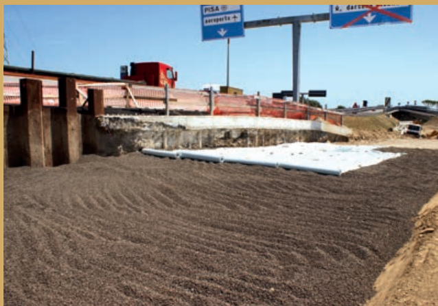
Svincolo di Pisa Centro - Rilevato stradale
