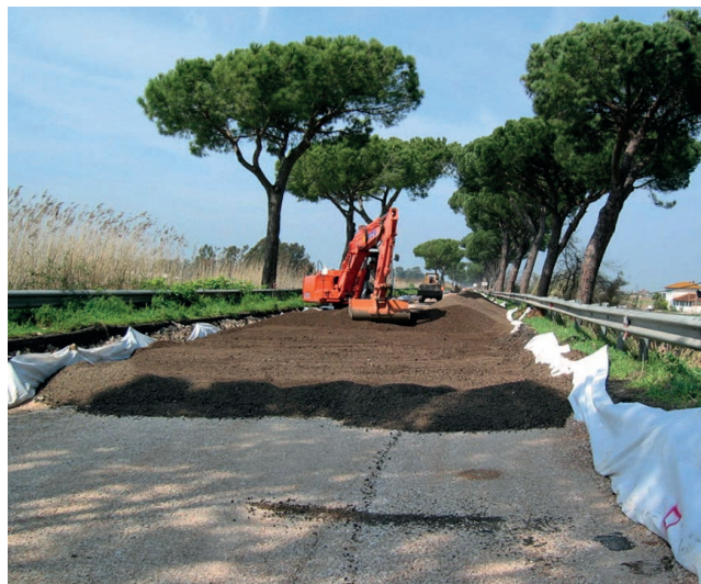
SS. 7 "Via Appia" (RM) - rilevato stradale.
