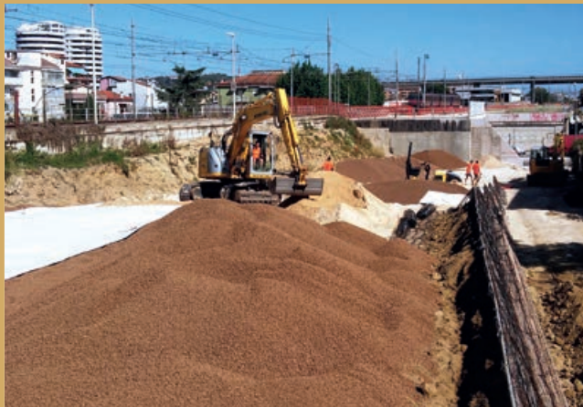
Pescara Porta Nuova - Rilevato ferroviario
