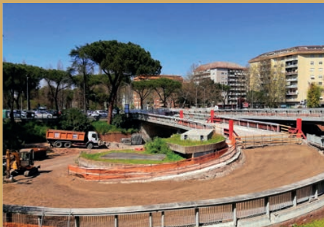
Roma EUR - Rilevato stradale
