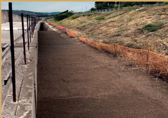
Autostrada A1, Firenze - Riempimento dietro parete laterale di galleria artificiale
