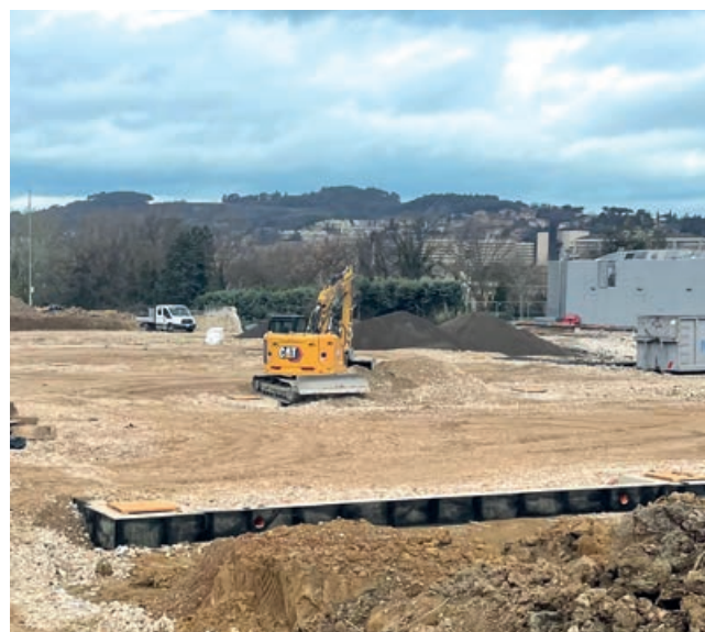
Fondazione compensata per capannone industriale a Torgiano (PG).
