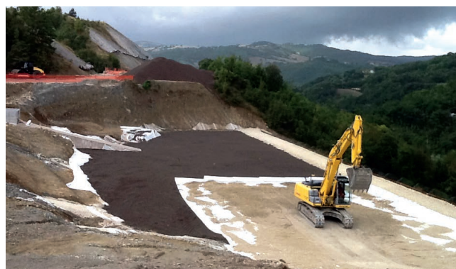
Rilevato su pendio a Valfabbrica (PG).
