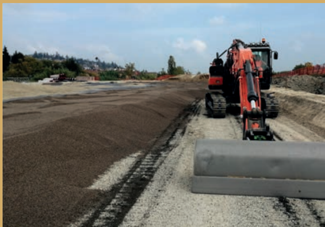
Svincolo di Rastignano (BO) - Rilevato stradale
