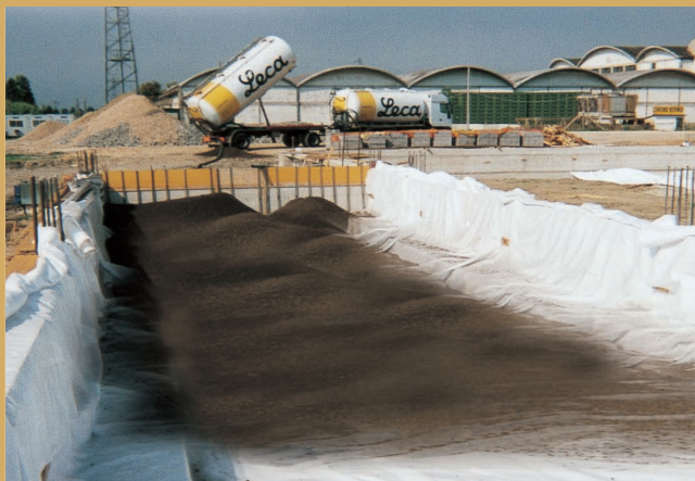
Interporto di Ferrara - Fondazione compensata sotto capannone
