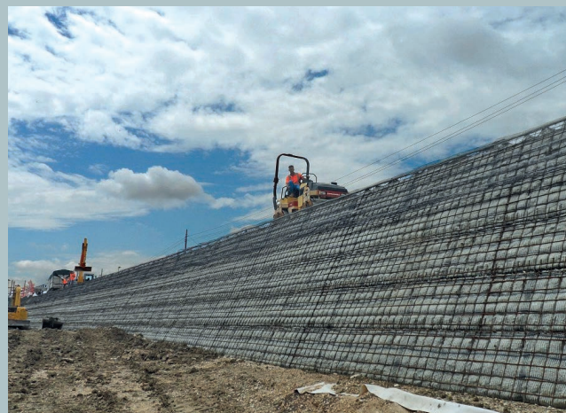
Contenimento laterale mediante terre rinforzate con geogriglia.
