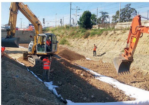
Ampliamento di un rilevato ferroviario a Pescara.
