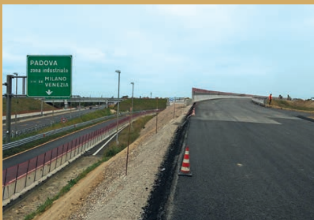
Interconnessione A4-A13 - Rilevato stradale
