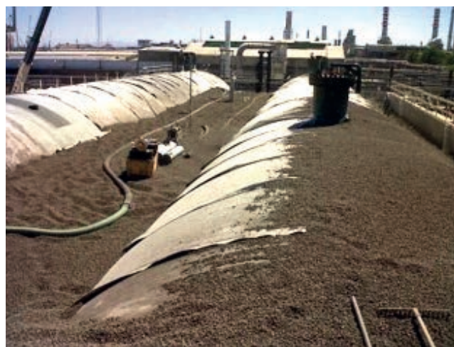
Tumulazione con argilla espansa di serbatoi a Ravenna.
