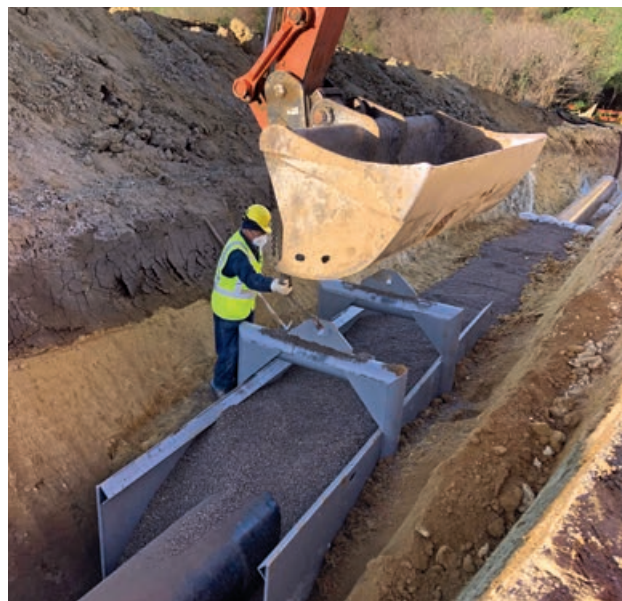
Allettamento con argilla espansa di tubazione in prov. di Fermo.
