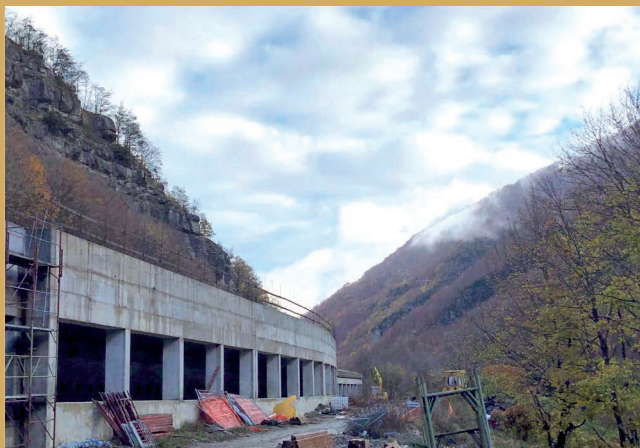
Crognaleto (TE) - Galleria paramassi
