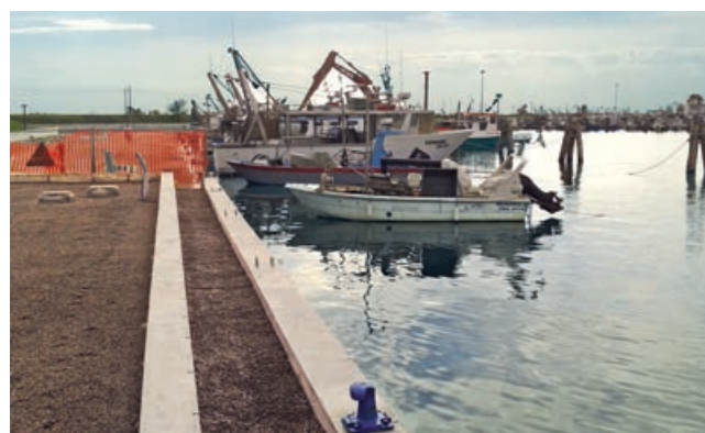
Ampliamento banchina porto di Goro (FE).
