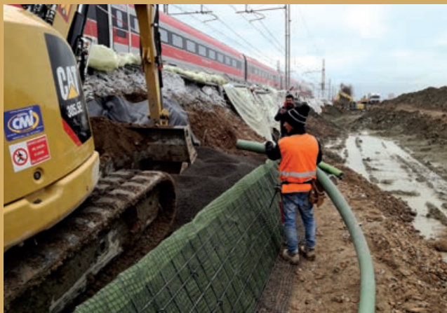
Poggio Renatico (FE) - Rilevato ferroviario
