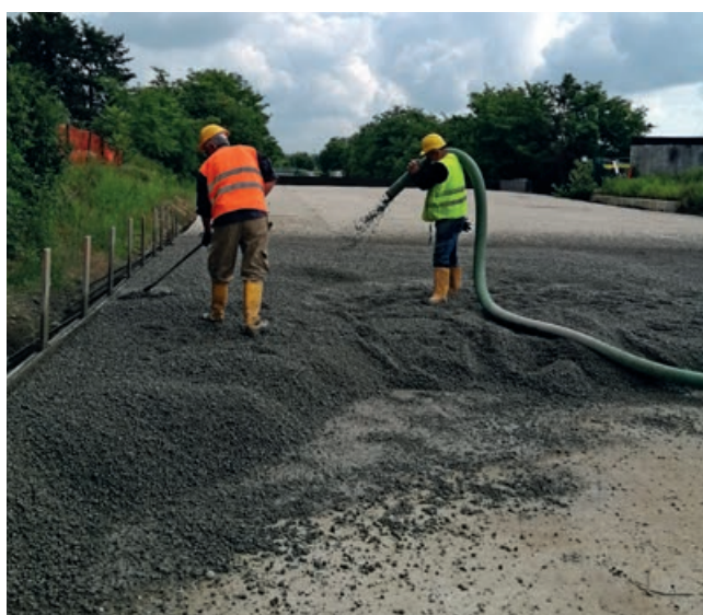
Leca cementata sopra galleria artificiale a Monza.
