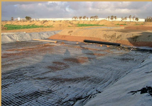
Interporto di Fiumicino - Fondazione compensata sotto capannone
