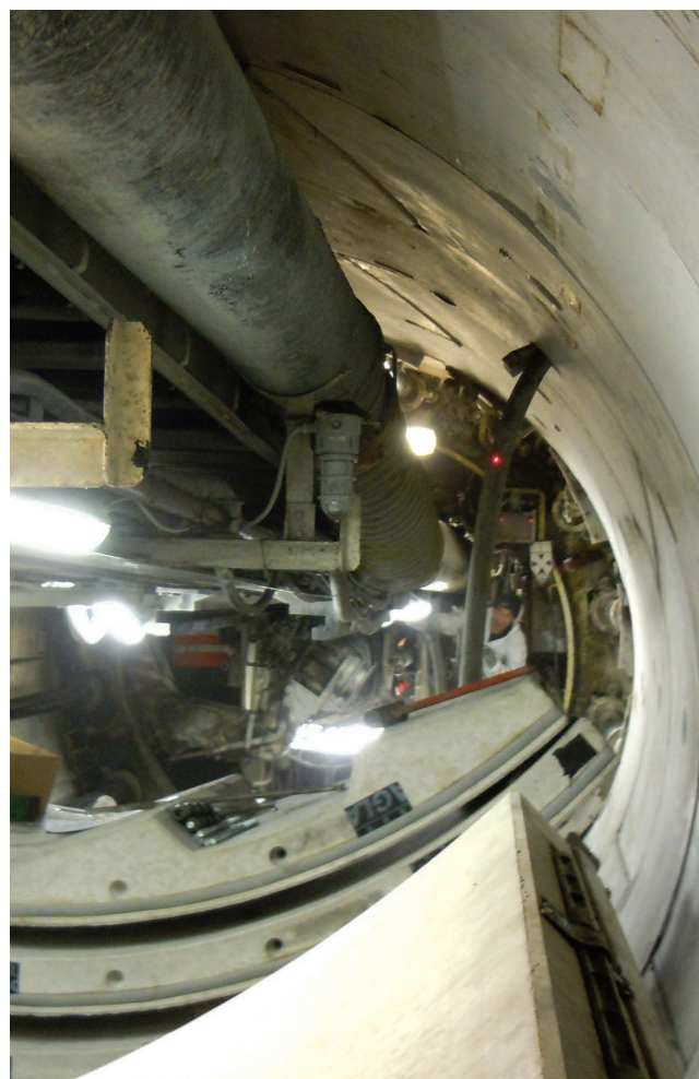
Galleria di sicurezza del G.S. Bernardo.
