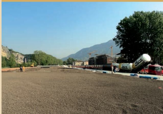
Trento - Fondazione compensata sotto capannone
