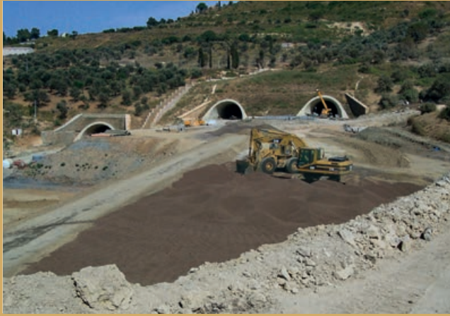
Autostrada Messina - Palermo Rilevato stradale
