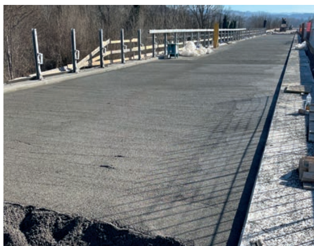
Massetto alleggerito su ponte E45 a Umbertide (PG).
