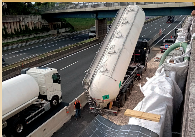
Autostrada A1, San Vittore - Riempimento dietro paratie di pali
