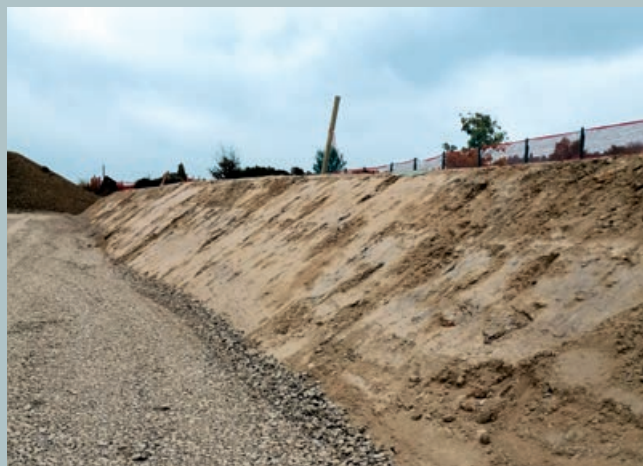
Contenimento laterale mediante argini in misto granulare.
