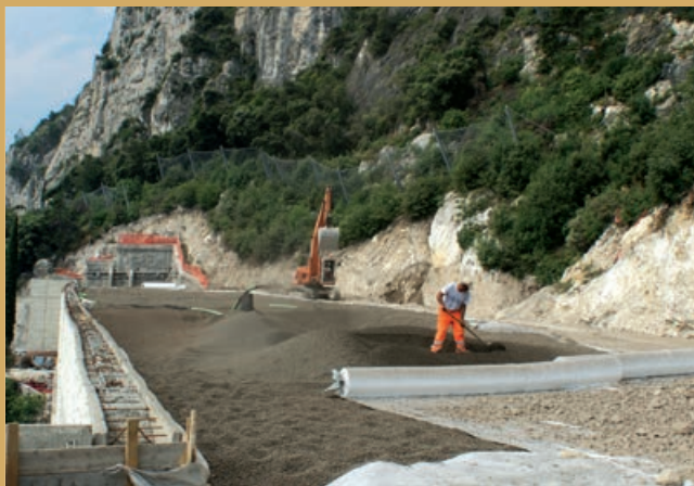
SS 45 bis Gardesana occidentale - Galleria paramassi
