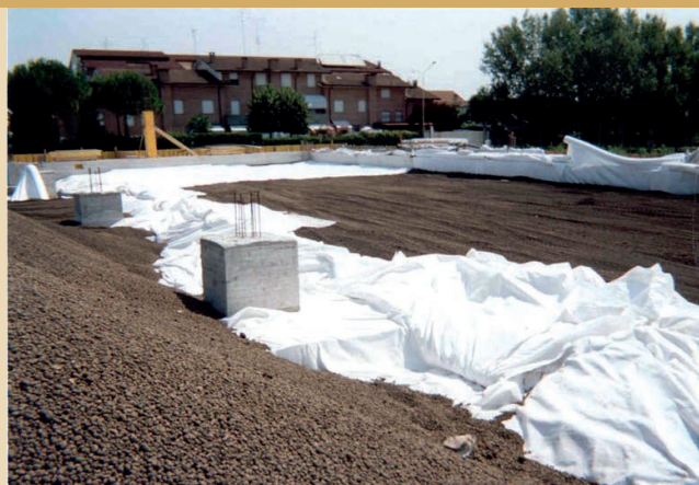
Interporto di Ferrara - Fondazione compensata sotto capannone
