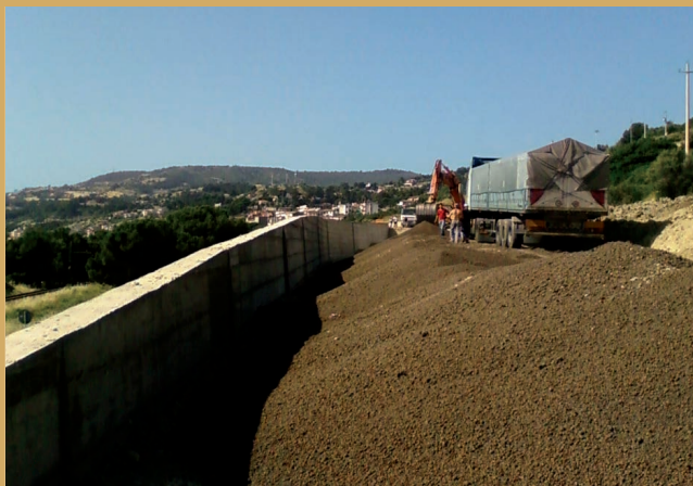
SS 106 Ionica - Riempimento dietro muro di sostegno
