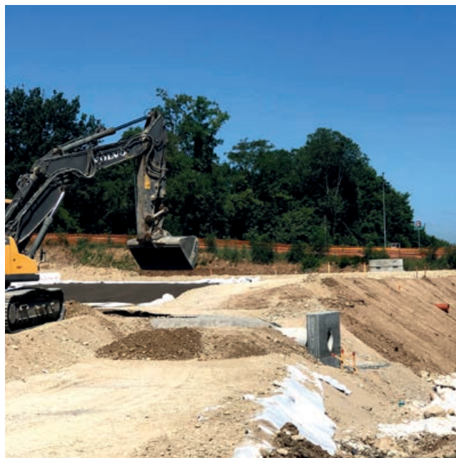
Peschiera del Garda (VR) - rilevato stradale.
