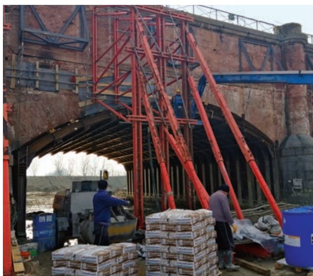
Consolidamento ponte in muratura con calcestruzzo leggero strutturale premiscelato R_{ck} 40 MPa.
