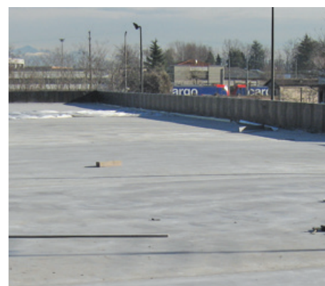
Pavimento industriale in copertura carrabile.
