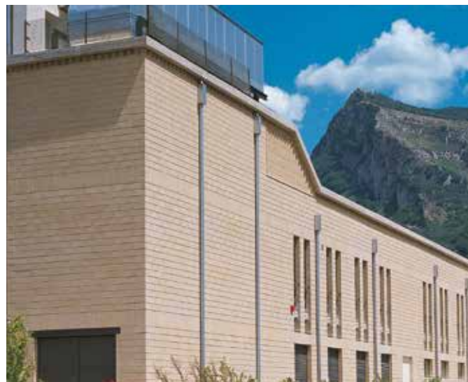
Parete esterna in Lecablocco Archittonico.
