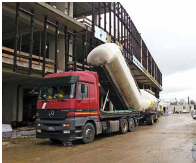
Preparazione del cantiere per il pompaggio di Leca TermoPiù sfuso con cisterna.
