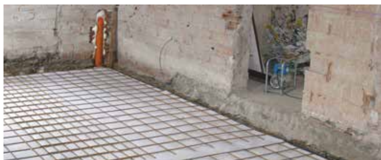
Stesura del tessuto non tessuto e della rete elettrosaldata.
