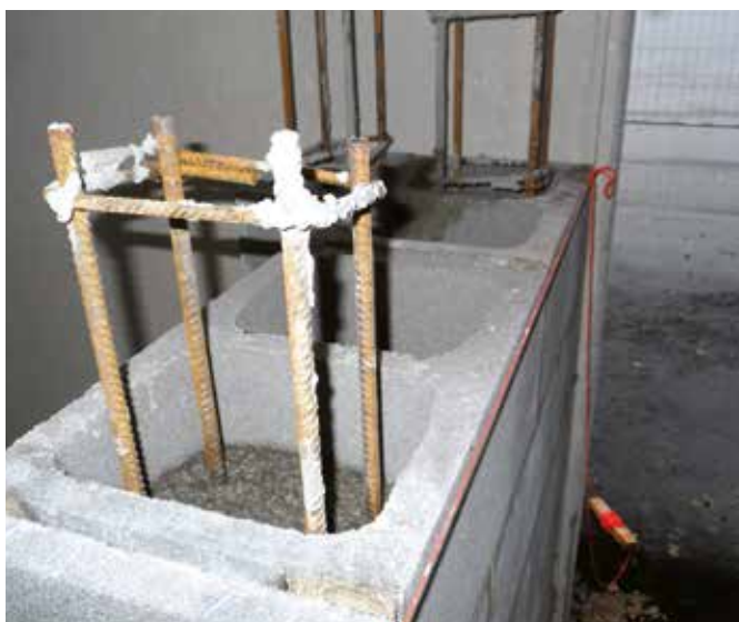
Irrigidimento verticale all'interno del Lecablocco Tagliafuoco B30x20x50 due fori facciavista.
