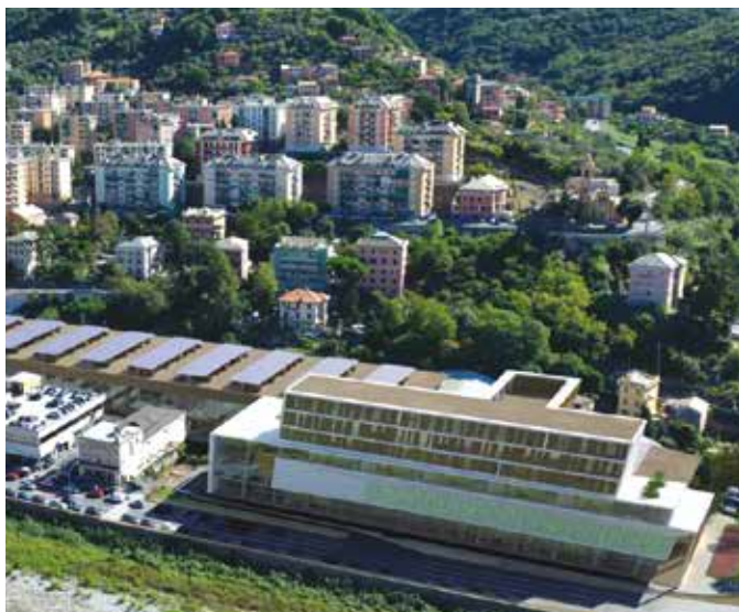
Area Ex Italcementi di Genova riconvertita a destinazione commerciale. Superficie con isolamento controterra: 1.600 m 2 .
