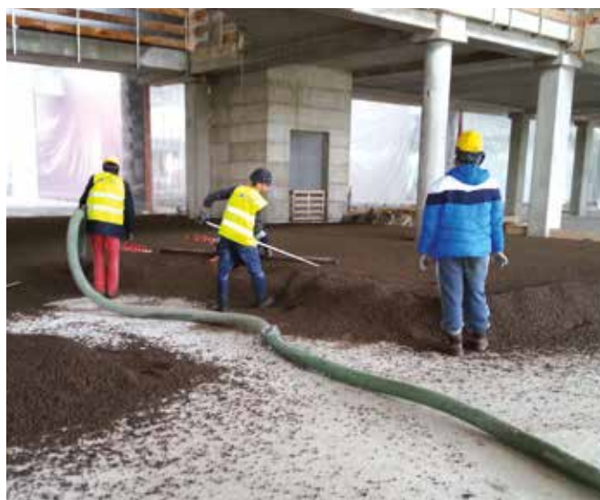
Stesura di Leca TermoPiù nello spessore desiderato e regolarizzazione della superficie.
