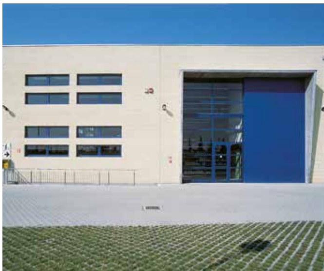
Parete esterna in Lecablocco Architettonico per un magazzino.
