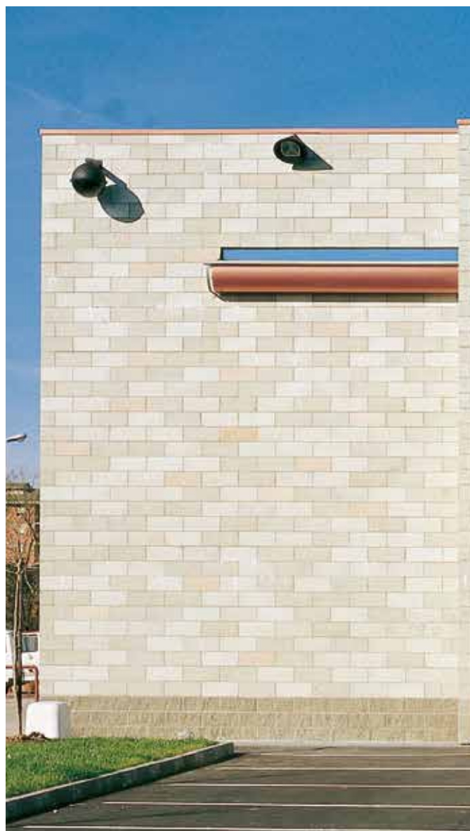
Parete esterna in Lecablocco Architettonico di grandi dimensioni di un Centro Commerciale.
