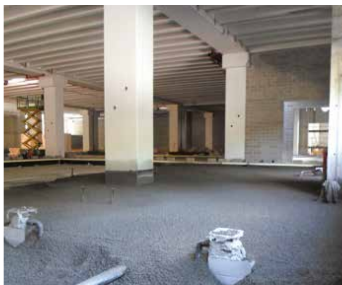
Stesura omogenea dello strato di Leca Termopiù cementato (strato medio 55 cm) su cui è stata fatta la pavimentazione industriale di circa 20 cm.
