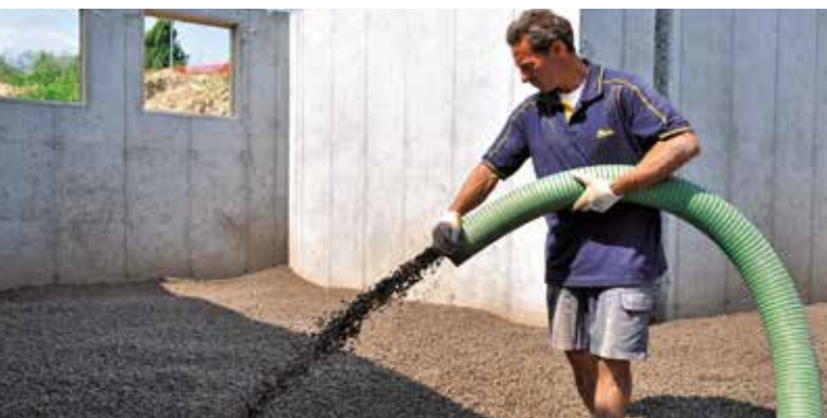
Pompaggio del TermoPiù sfuso – fino a 100 m di distanza.
