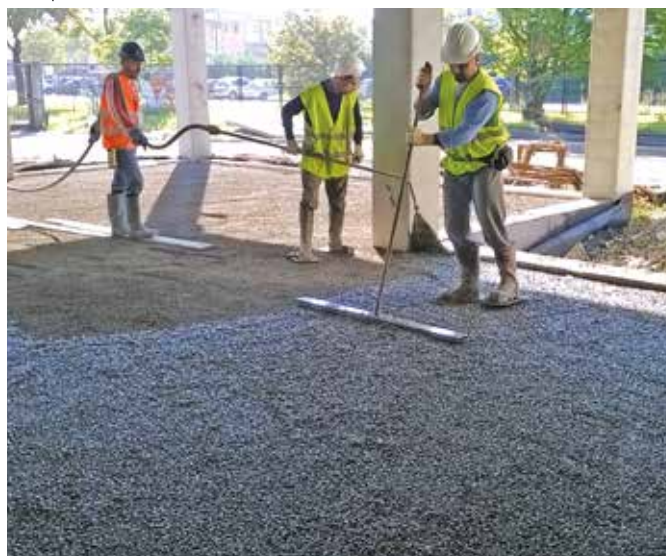
Imboiaccatura della superficie di Leca TermoPiù e sistemazione superficiale. La boiaccia cementizia penetra di circa 5 cm nello strato di TermoPiù.
