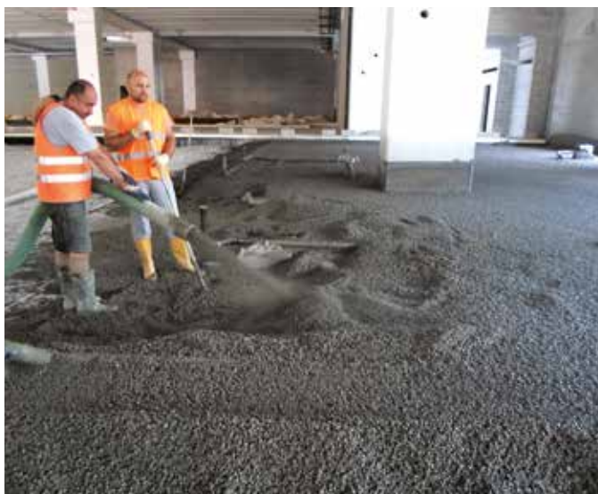
Pompaggio di Leca Termopiù cementato con boiacca composta da ca. 130-150 kg di cemento per m 3 di argilla espansa.
