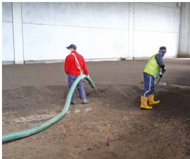
Pompaggio di Leca TermoPiù sfuso e staggiatura.
