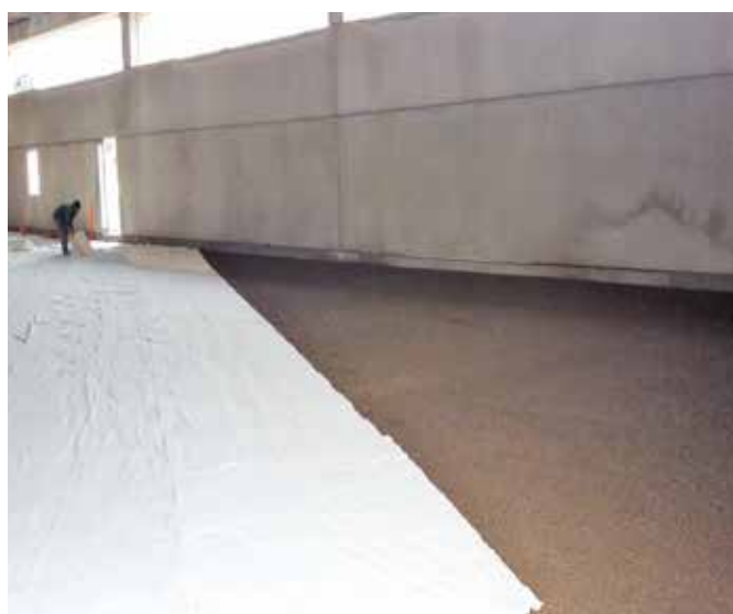
Stesura di un idoneo strato separatore (tessuto non tessuto) su Leca TermoPiù sfuso.
