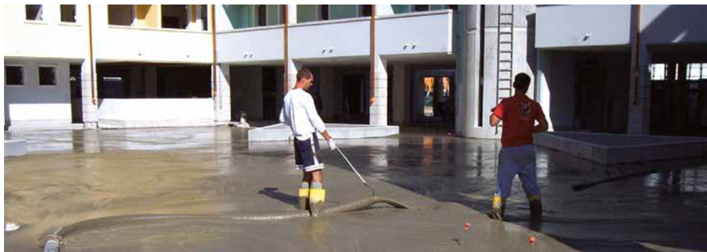
Betoncino leggero isolante in copertura durante la fase di posa.
