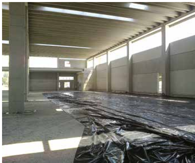
Stesura sul terreno di uno strato separatore – telo in polietilene.
