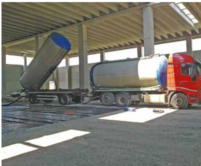
Preparazione del cantiere per il pompaggio di Leca TermoPiù con cisterna.
