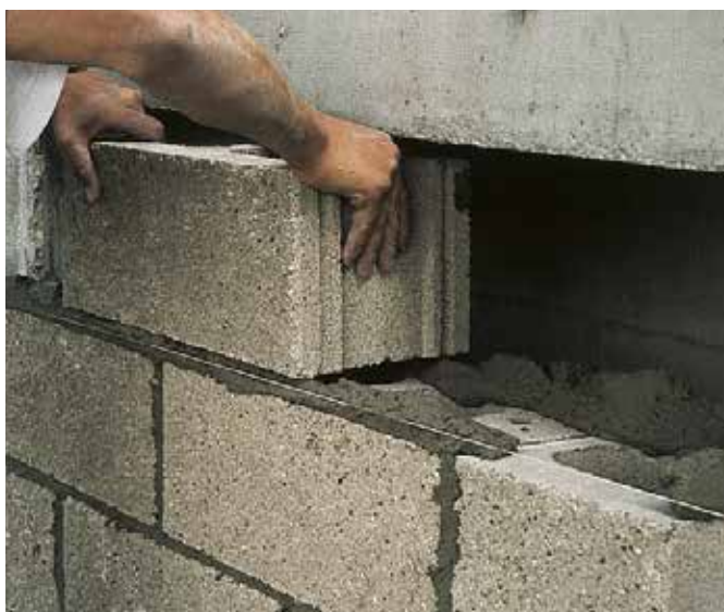
Posa di una parete esterna in Lecablocco Architettonico.
