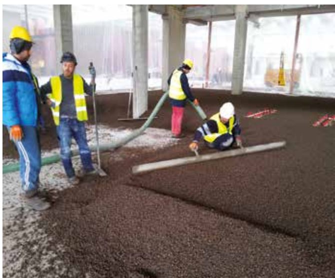
Leca TermoPiù è steso uniformemente contro terra.
