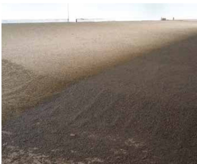
Strato di Leca TermoPiù steso uniformemente sulla superficie.
