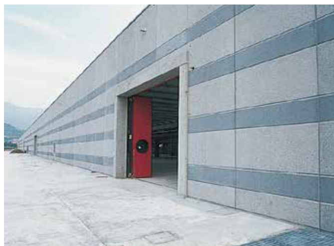
Pannelli prefabbricati alleggeriti con argilla espansa.
