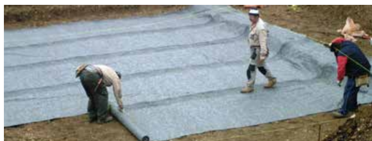
Stesura del tessuto non tessuto sul terreno di scavo.
