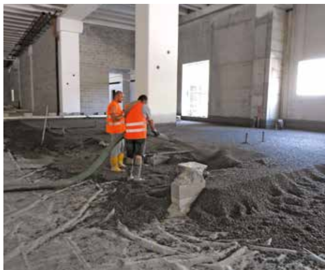
Pompaggio di Leca Termopiù cementato nello spessore desiderato.
