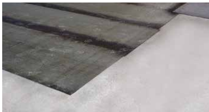
Posa diretta della guaina bituminosa.
