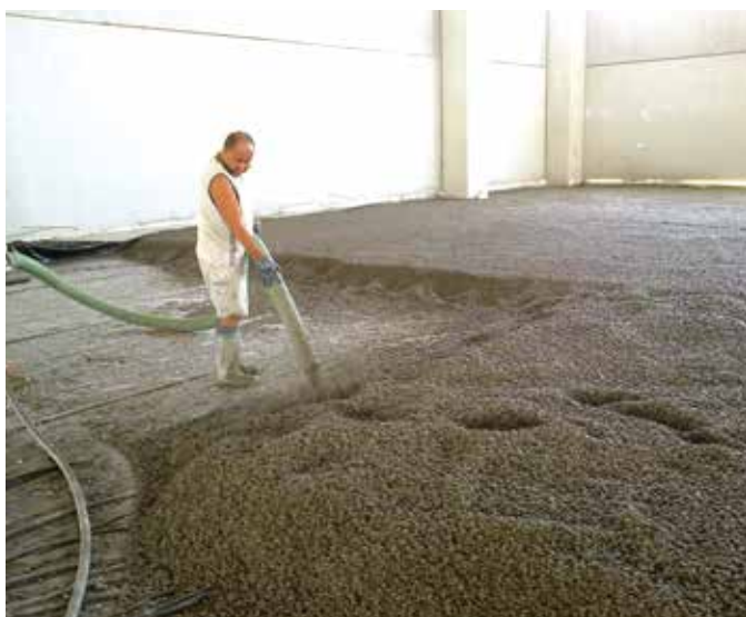
Pompaggio di Leca TermoPiù cementato con boiaccia composta da ca. 130-150 kg di cemento per m 3 di argilla espansa.
