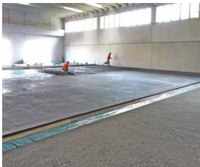
Sottofondo leggero in LecaCem Classic e massetto alleggerito in LecaMix Forte Professional posati sopra la soletta in calcestruzzo.
