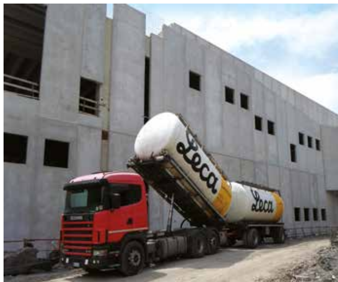
Preparazione del cantiere per il pompaggio di Leca Termopiù con idoneo mezzo cisternato.
