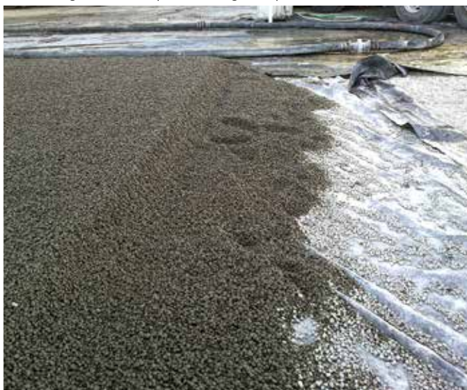
Vespaio controterra in Leca TermoPiù cementato.
