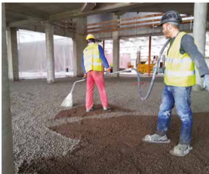
Imboiaccatura della superficie di Leca TermoPiù (miscela con rapporto 0,7, per 1 m 3 di boiaccia si impastano 1000 kg di cemento e 700 l di acqua).
