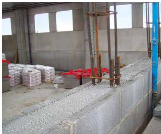
Getto del cordolo orizzontale di irrigidimento all'interno del Lecablocco Architrave.
