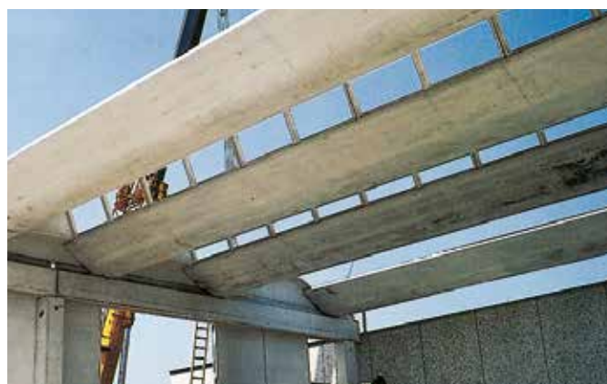
Tegoli di copertura in calcestruzzo alleggerito.
