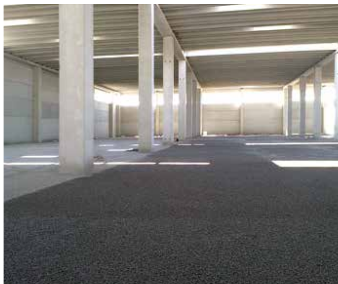
Vespaio controterra in Leca TermoPiù cementato prima della posa della soletta in calcestruzzo.
