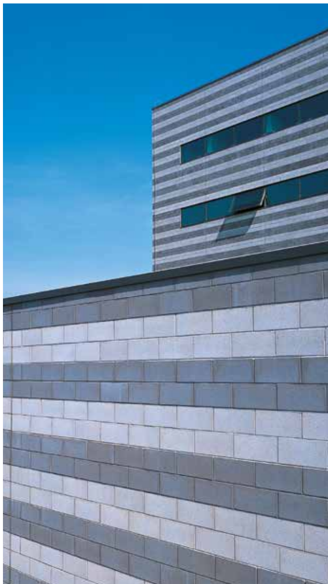
Parete di tamponamento di un Parco Scientifico Tecnologico in Lecablocco Archittonico facciavista di due colorazioni differenti.
