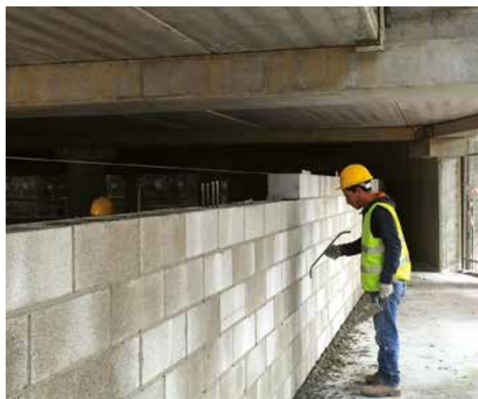
Posa della parete facciavista con stilatura dei giunti.
