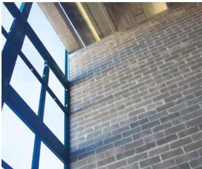
Parete in Lecablocco Tagliafuoco B30x20x50 2 fori facciavista di suddivisione degli ambienti.
