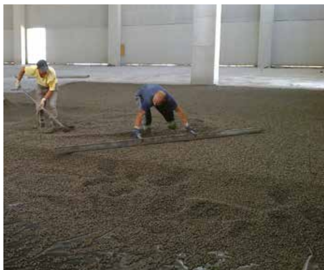
Regolarizzazione dello strato in Leca TermoPiù cementato.
