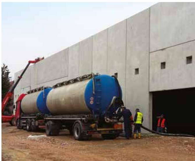
Preparazione del cantiere per il pompaggio di Leca TermoPiù sfuso con cisterna (pompaggio fino a 100 m di distanza).
