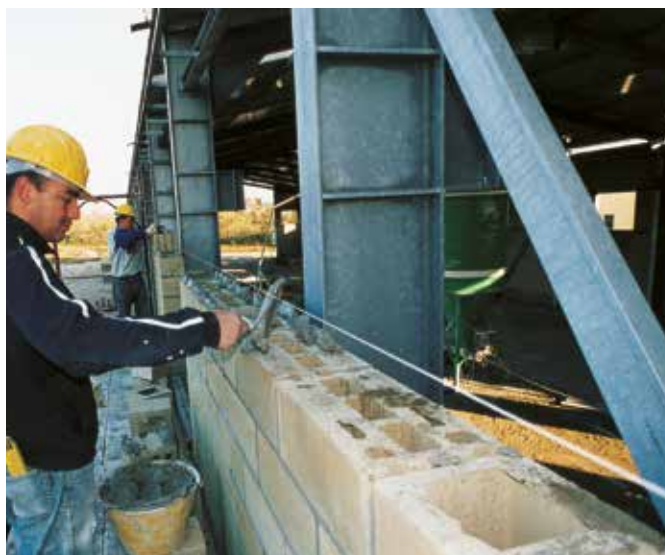
Posa del Lecablocco Archittonico come parete di tamponamento di una struttura prefabbricata metallica.
