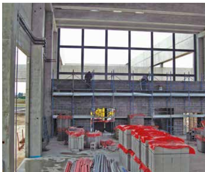
Parete di compartimentazione di grandi dimensioni in corso di realizzazione.
