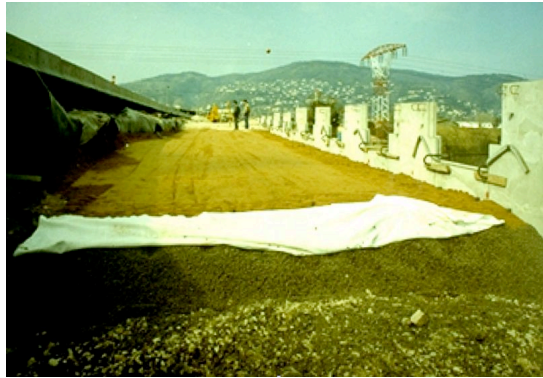
Fig. 3.6 : sequenza di lavoro: posa del geotessile non tessuto, del primo strato di argilla espansa e del primo strato di misto.
