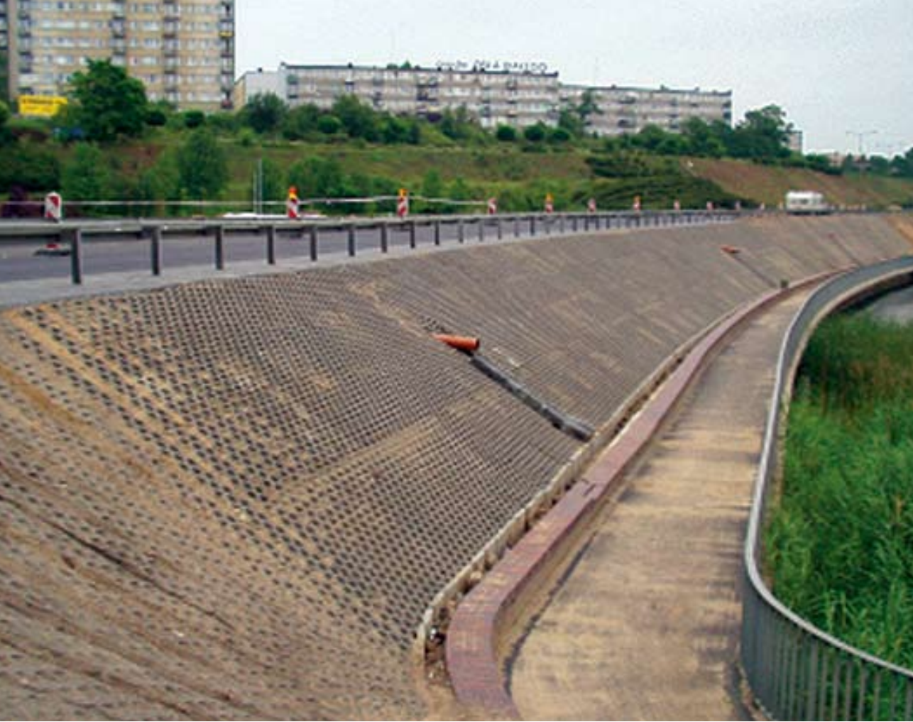
Ripristino sede stradale con muro di sostegno. Gniezno - Polonia
