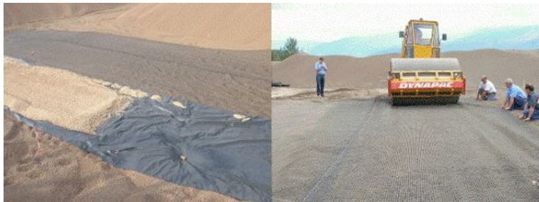
Fig. A25 : preparazione del poligono sperimentale (a) e realizzazione della prova su piastra (b).
