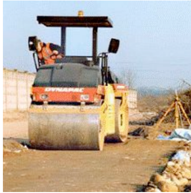
Fig. 4.1: rullo per la compattazione del materiale in sito.
