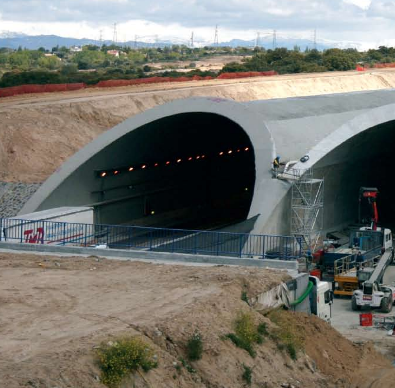
Fase 1: Costruzione del falso tunnel sulla nuova circonvallazione
